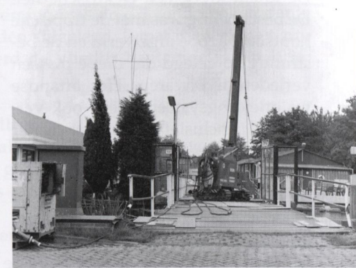
De aanleg van een nieuwe brug.
